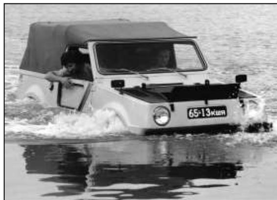
Нива походила на стандартную модель только колесной базой это был джип с упрощенным кузовом авто и имело открытый верх с тентом, откидывающееся лобовое стекло, насос для откачки воды, авто по воде двигалось за счет вращения колес на воде 9 км/год, на суше 115 км/год. Автомобиль также как и Ягуар не добрался до производства.
